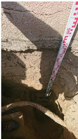
fot. b) odkrywka fundamentu
