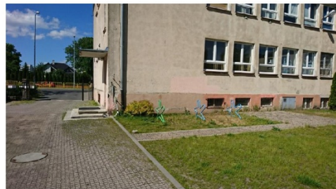
fot. a) miejsce wykonanej odkrywki fundamentu
